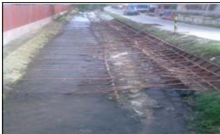
Gambar 2.7 Sungai Senapelan Sedang di Bangun Turap
